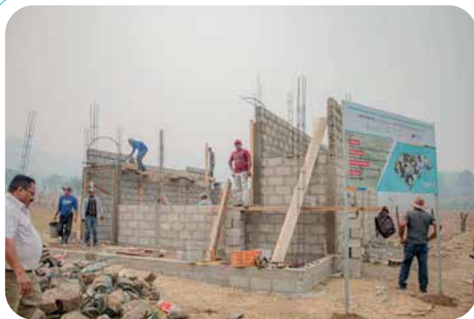
Reparación, ampliación y/o construcción de centros educativos. Orica F.M.
